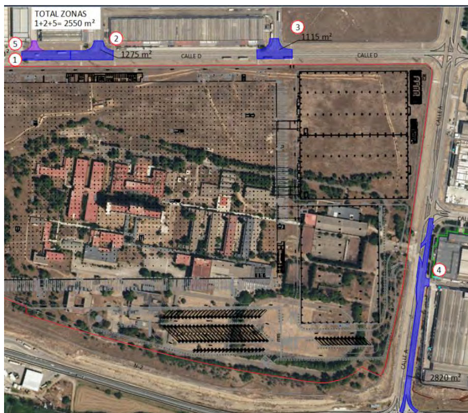
Zonas de pavimento a renovar
