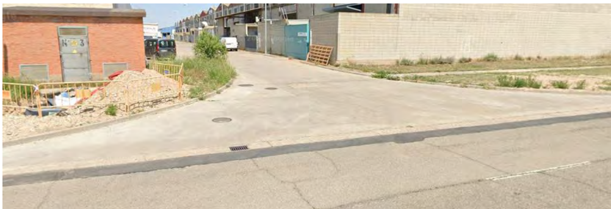
Conexión calle D con calle Q a renovar
